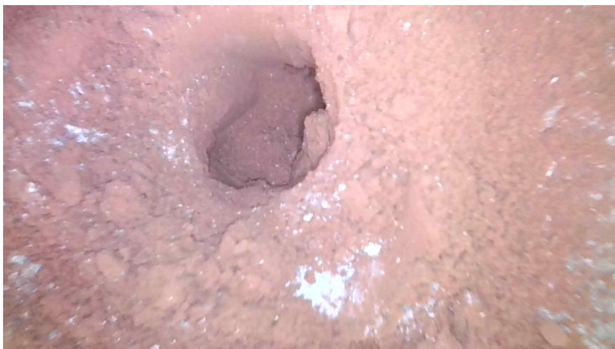
Obr. 1- Místní sonda – Příčka – Cihla plná pálená
