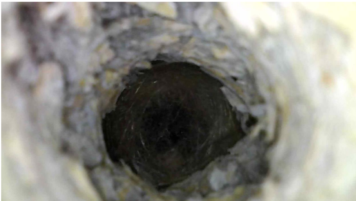
Obr. 6- Místní sonda – Strop 6.np – Heraklit
