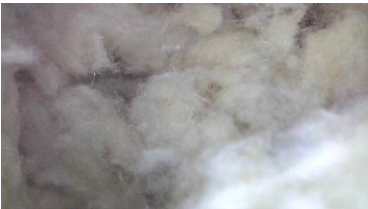
Obr. 7- Místní sonda – Strop 6.np – Skelná vata
