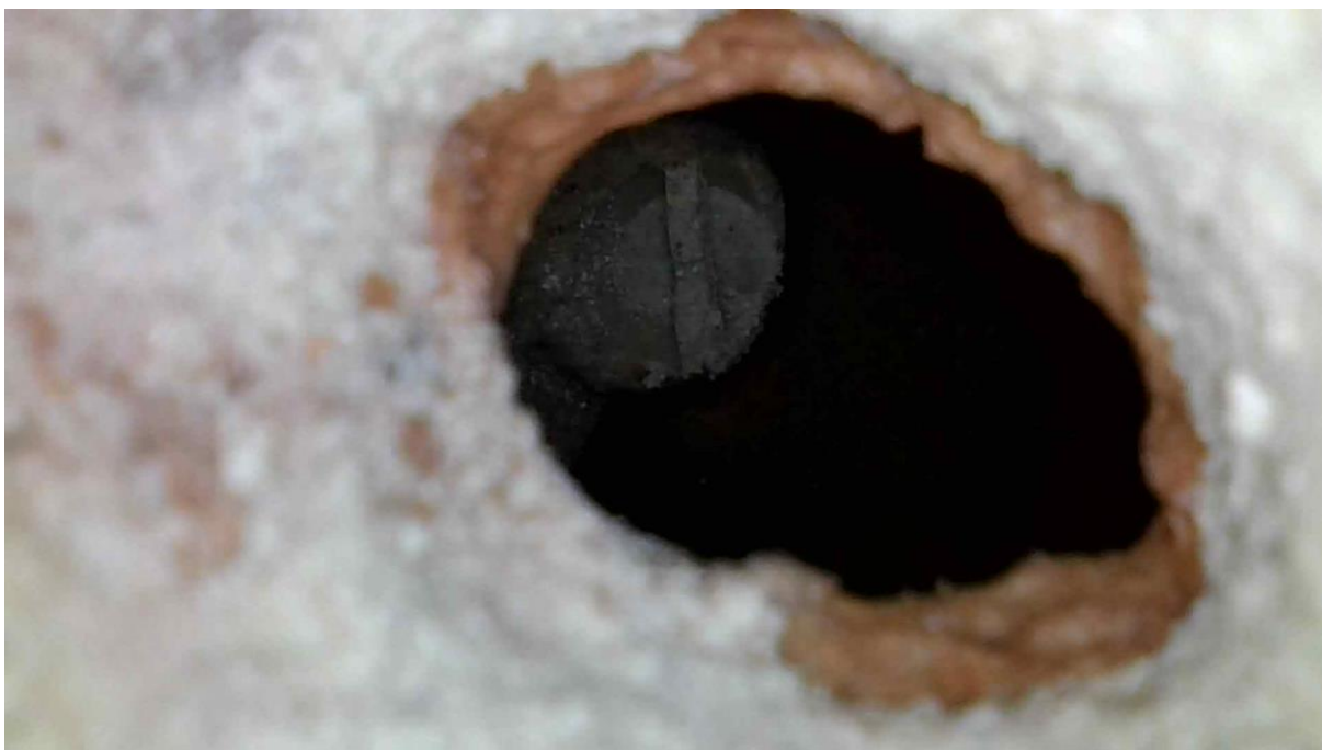
Obr.3- Místní sonda – Strop 4.np – Hurdis
