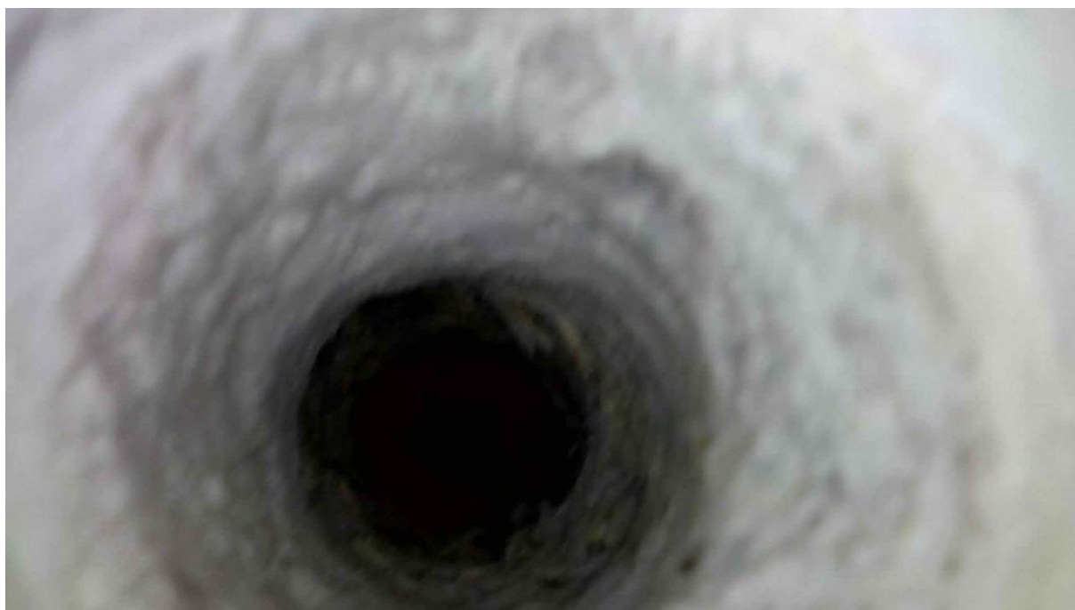
Obr.2- Místní sonda – Betonová mazanina v podlaze
